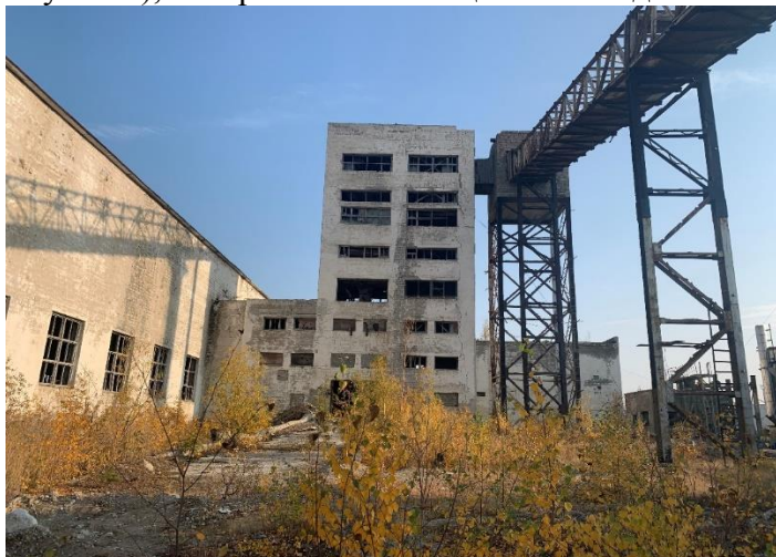
Рисунок 1 –Бывшее здание кирпичного завода, 1958 года постройки (п. Марха, Якутия)
